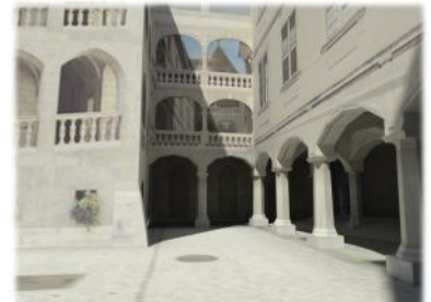
Photo numérisée de la structure du bâtiment
